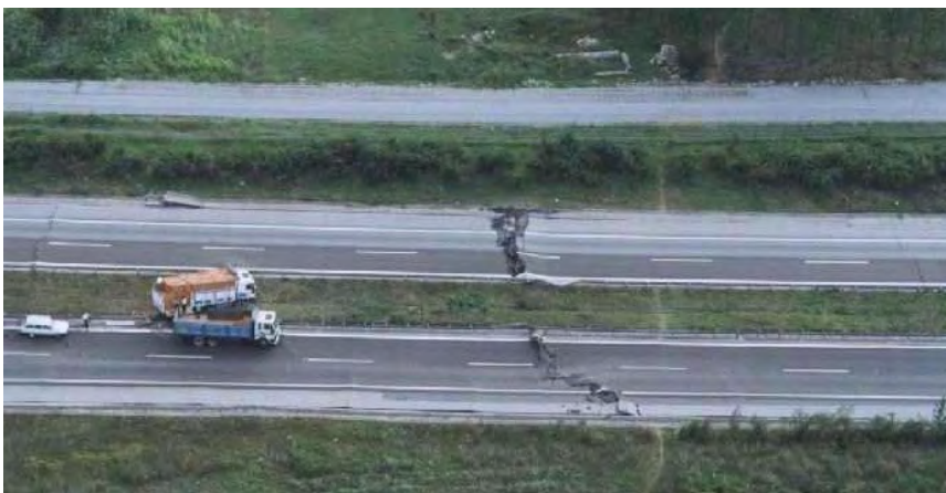
Σχήμα 3.18: Αστοχία οδοστρώματος εθνικής οδού στην Τουρκία (Kocaeli, 1999).
