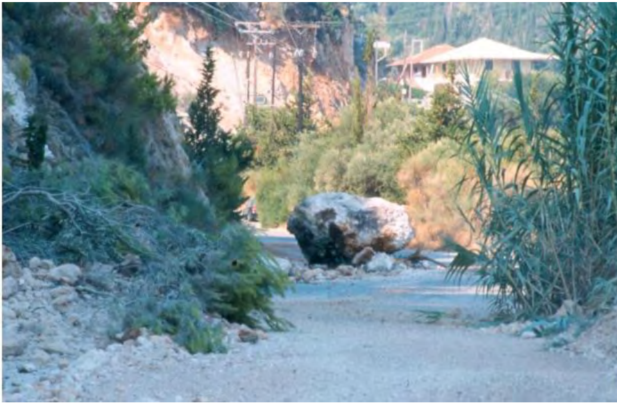
Σχήμα 3.20: Λευκάδα: κατολισθήσεις πρανών στο οδικό δίκτυο .
