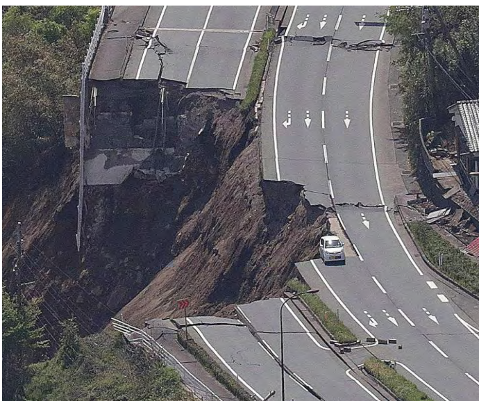
Σχήμα 3.28: Κατολίσηση πρανούς και καταστροφή αυτοκινητόδρομου της Νέας Ζηλανδίας .
