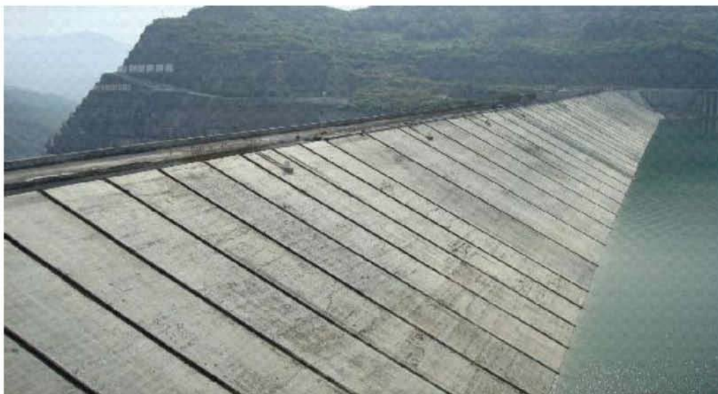
Σχήμα 1.1: Φράγμα Shuibuya (CFRD), ύψους 233m, China [13].
