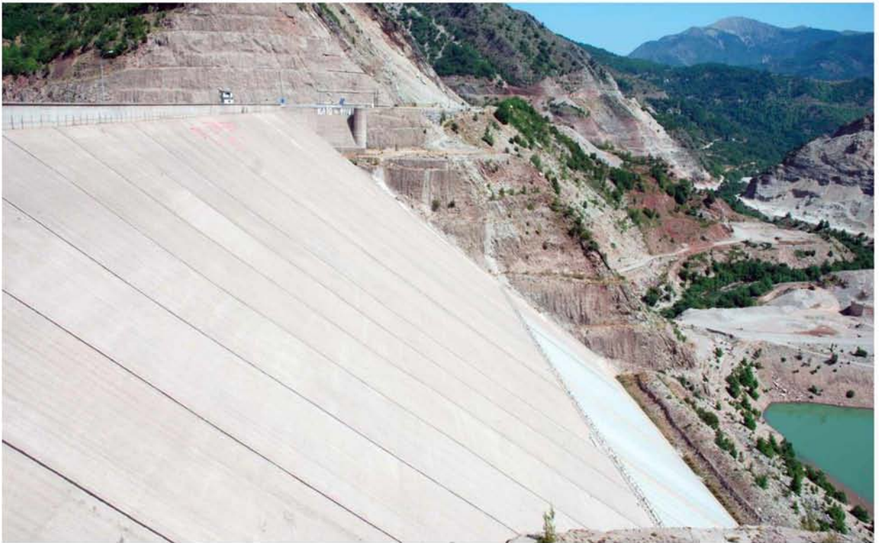
Σχήμα 3.2: Φράγμα Μεσοχώρας ανάντη πλευρά [22]
