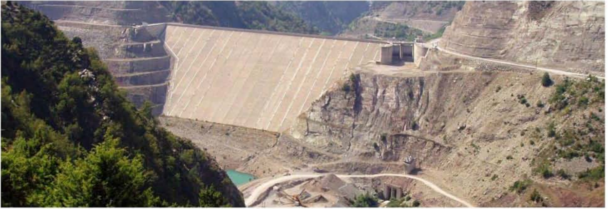
Σχήμα 3.1: Φράγμα Μεσοχώρας ανάντη πλευρά [22]
