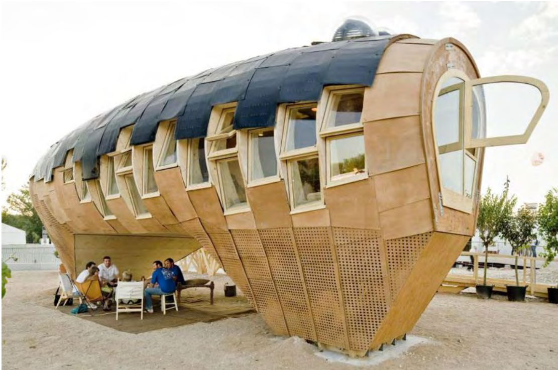
Εικόνα 10: Πρωτότυπη κατασκευή Fab Lab House
