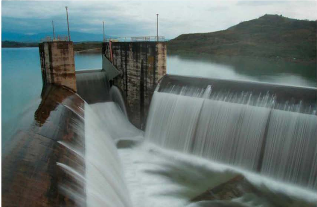
Εικόνα 2.8: Υπερχειλιστής φράγματος Πηνειού
