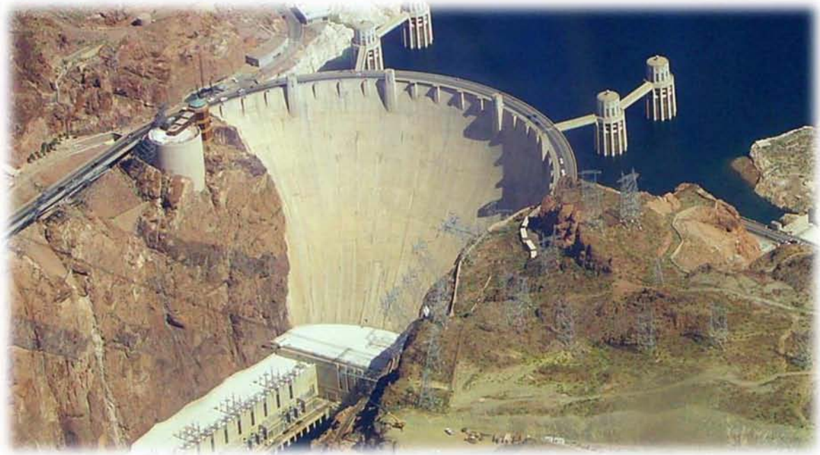
Εικόνα 2.6: Φράγμα Hoover, ΗΠΑ
