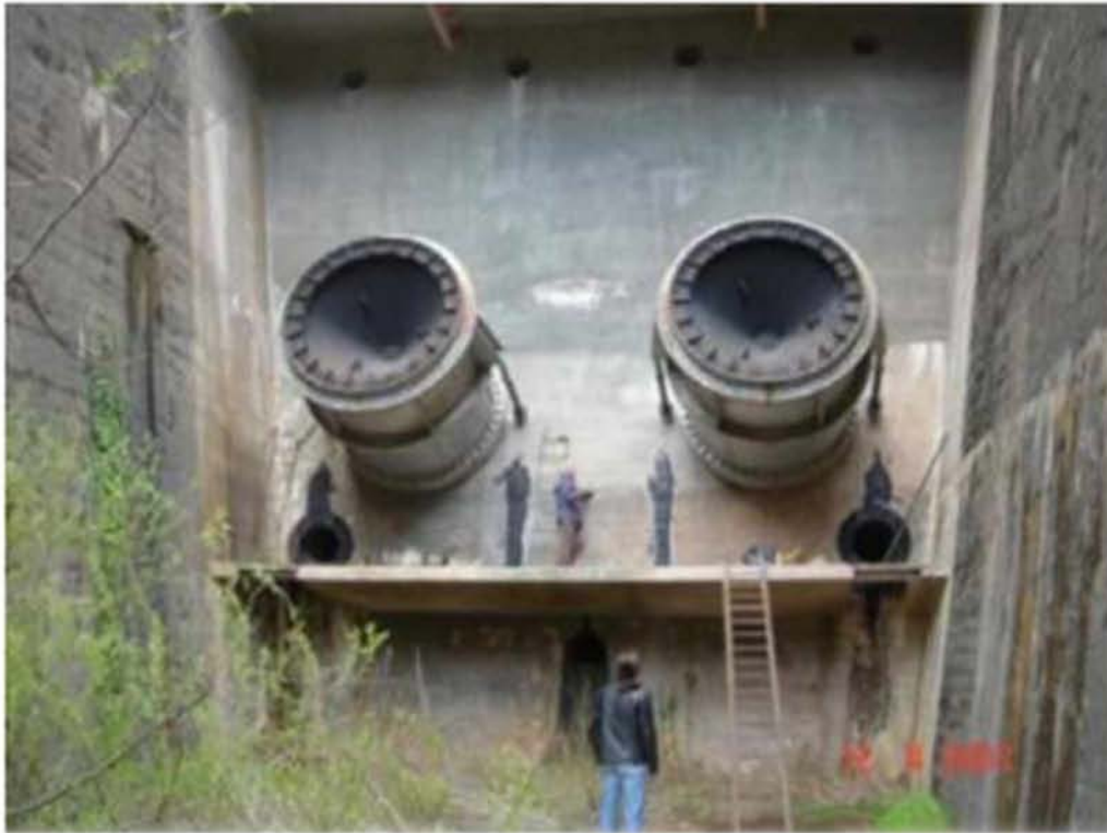
Εικόνα 2.10: Έξοδος εκκενωτή πυθμένα φράγματος ταυρωπού
