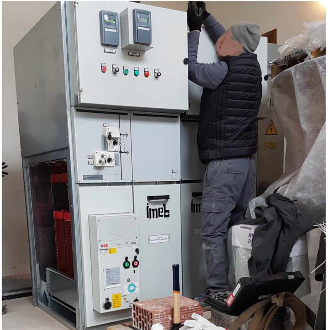
Εικόνα 5.5: Πίνακας 20 kV
