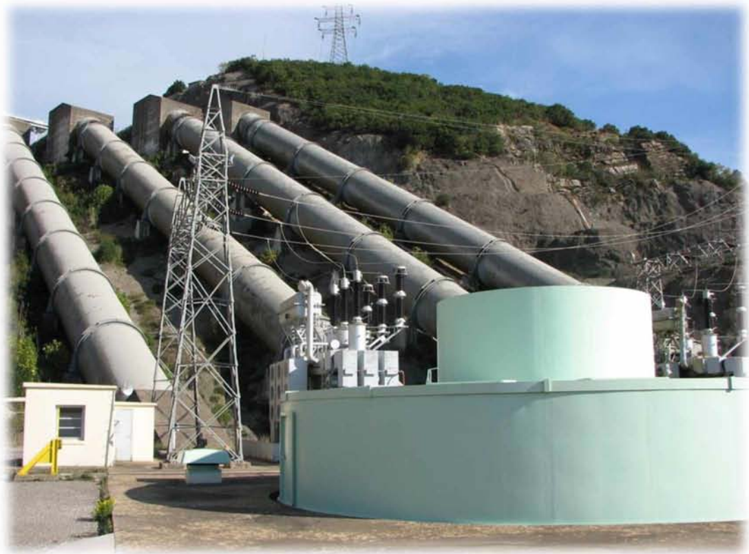
Εικόνα 2.11: Αγωγοί πτώσης υδροηλεκτρικού σταθμού Καστρακίου
