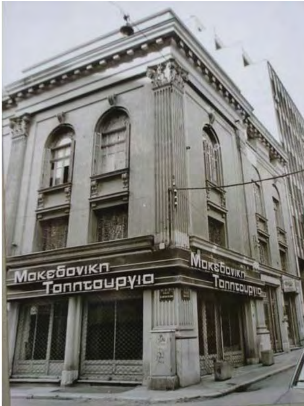
Εικόνα 26 Η γωνία των οδών Καθολικών και Βηλαρά πριν την κατεδάφιση του ορόφου.
