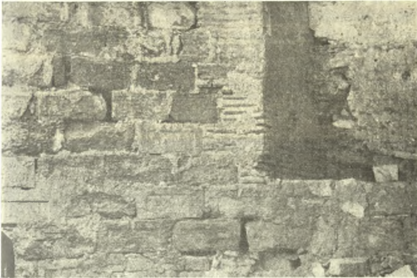
Εἰκ. 9. Ἀρχαῖα ἀρχιτεκτονικὰ μέλη χρησιμοποιηθέντα διὰ τὴν κατασκευὴν τῆς ἀψίδος.
