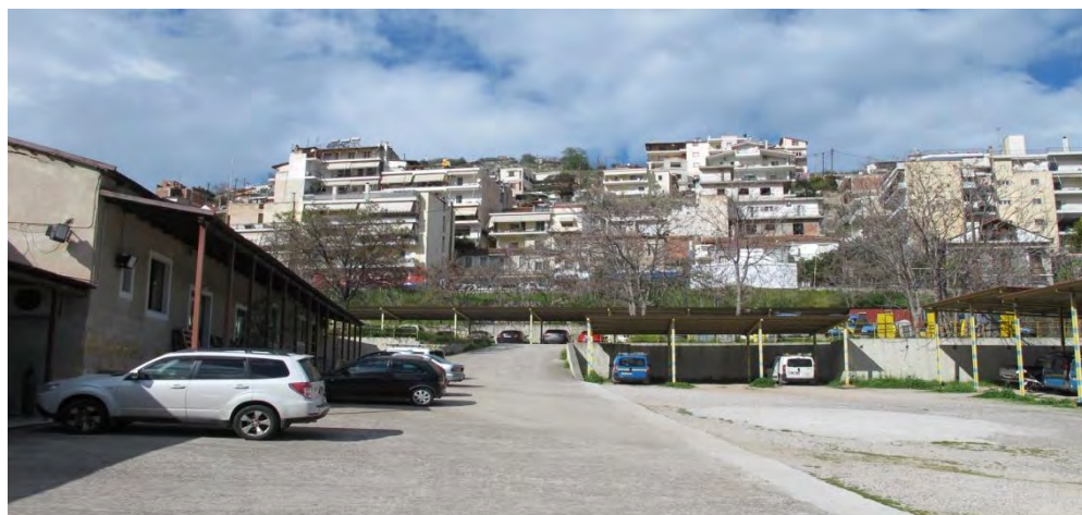
Εικ. 104: Εγκαταστάσεις ΟΤΕ Πηγή: Προσωπικό αρχείο
