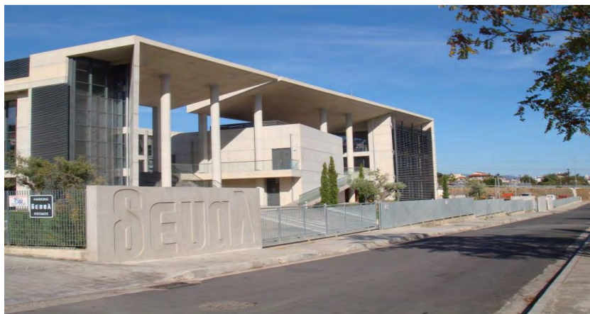
Εικ. 98: Βιοκλιματικό κτίριο ΔΕΥ Λαμίας Πηγή: Προσωπικό αρχείο
