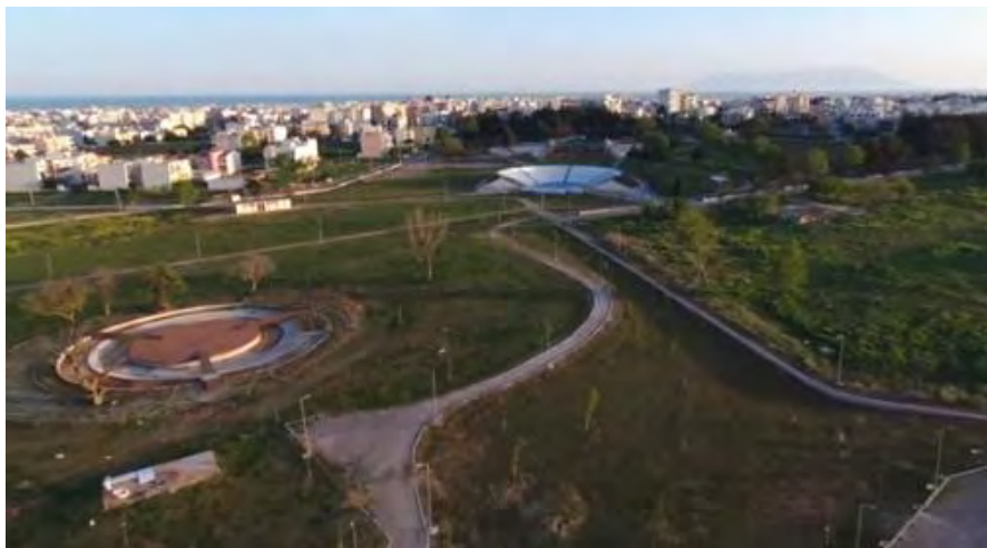
Εικ. 65: Το πάρκο κατά την εκτέλεση εργασιών Πηγή: https://reportal.gr/2017/05/06...CE%BB/
