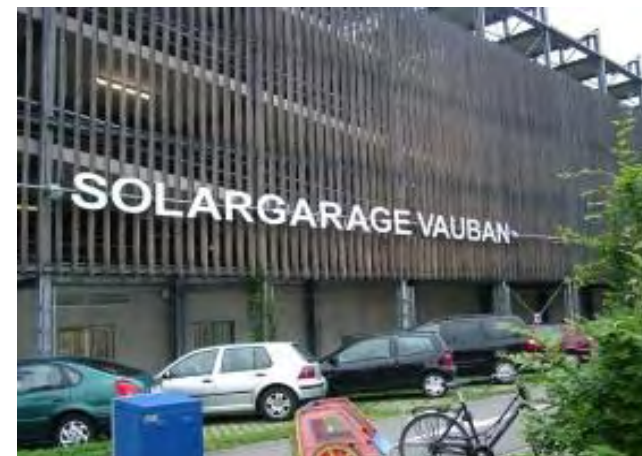
Εικ. 22 : Πολύροφο κτίριο στάθμευσης Πηγή: https://www.vauban.de/en/topics/history/276-an-introduction-to-vauban-district
