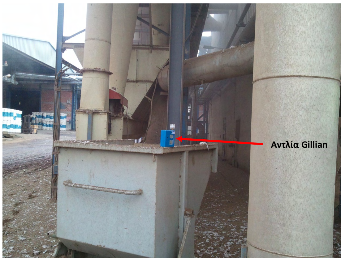
Εικόνα 10. Λήψης στατικού δείγματος εισπνεύσιμης σκόνης σε εκκοκκιστήριο βάμβακος.
