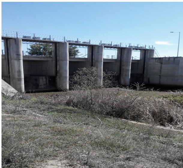
Φωτογραφία 2 – Φράγμα Μικρού Εύδριου
