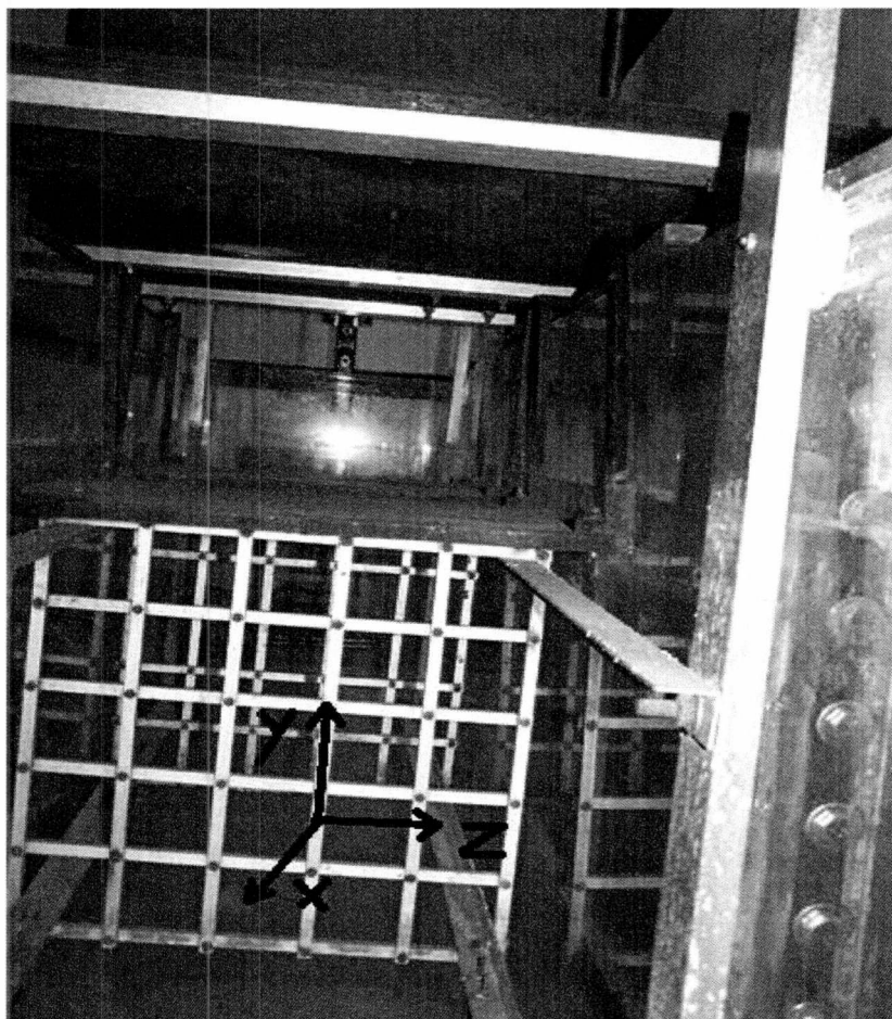
Εικόνα 3.3- Εσωτερική όψη των πλεγμάτων
