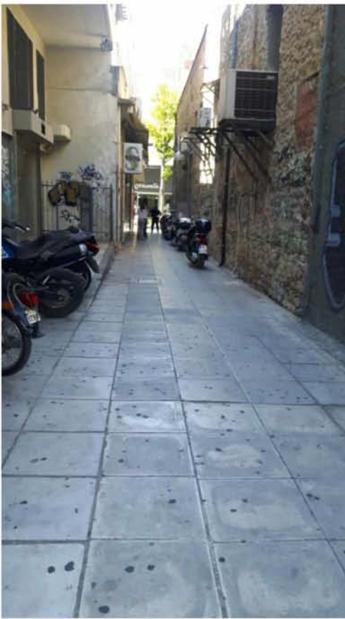
Πεζόδρομος επί της οδού Ανδρούτσου, Πηγή: Προσωπικό αρχείο
