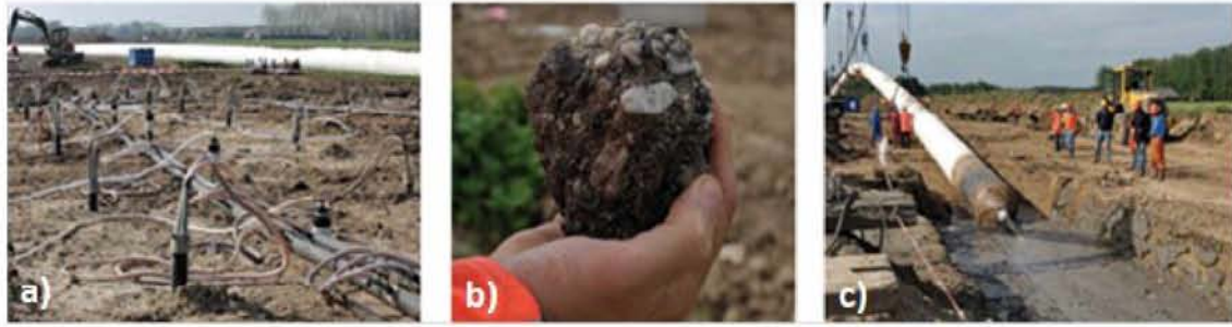
Σχήμα 3.12 α) Εγκατάσταση επαναλαμβανόμενων χώρων αποθήκευσης, β) Δείγμα του σταθεροποιημένου χαλικώδους εδάφους έπειτα από την εφαρμογή της μεθόδου MICP, γ) Εγκατάσταση σωληνώσεων έπειτα από οριζόντια διάτρηση (Dejong, 2013).
