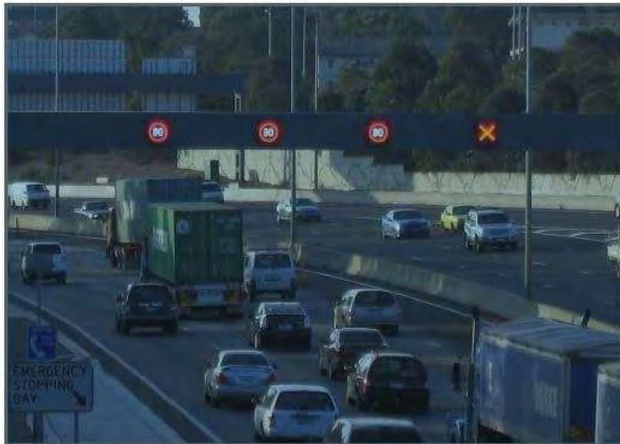
Εικόνα 23 LUS σε γερανογέφυρα σε αυτοκινητόδρομο.
