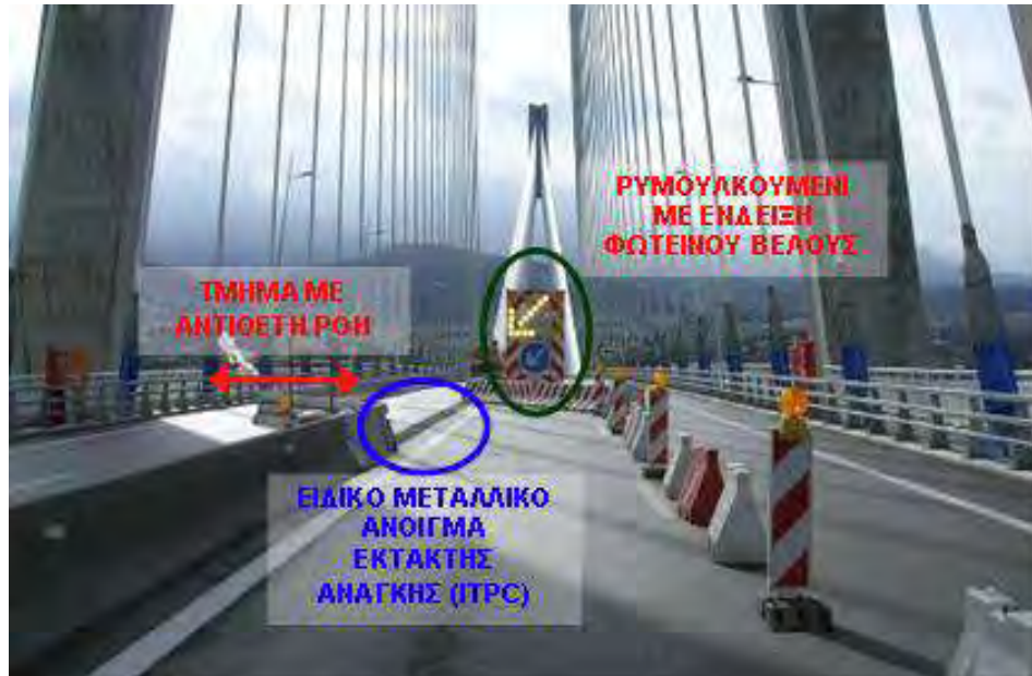
Εικόνα 47 Κυκλοφορία αντίθετης ροής –Ειδικά ανοίγματα έκτακτης ανάγκης (ΙΤΡC) με τη βοήθεια φορητών VMS στη γέφυρα Ρίου- Αντίρριου
