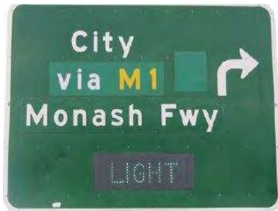
Εικόνα 29 Πινακίδα FCS με πινακίδα κατεύθυνσης που συναντάται συνήθως με τα RTIS
