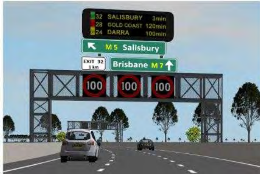
Εικόνα 13 Τριπλή συστέγαση VMS, σήματα κατεύθυνσης και VSL / LCS
