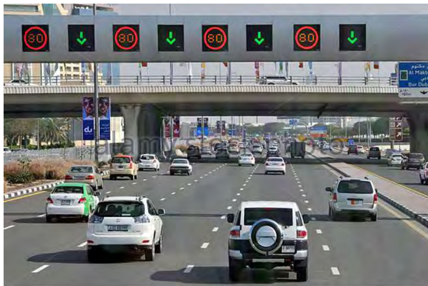
Εικόνα 22 LUS σε γερανογέφυρα σε αυτοκινητόδρομο
