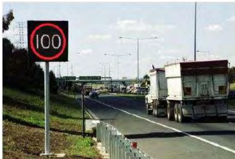
Εικόνα 11 VSL μέσα από στηθαία ασφαλείας εγκατεστημένα στο πλάι
