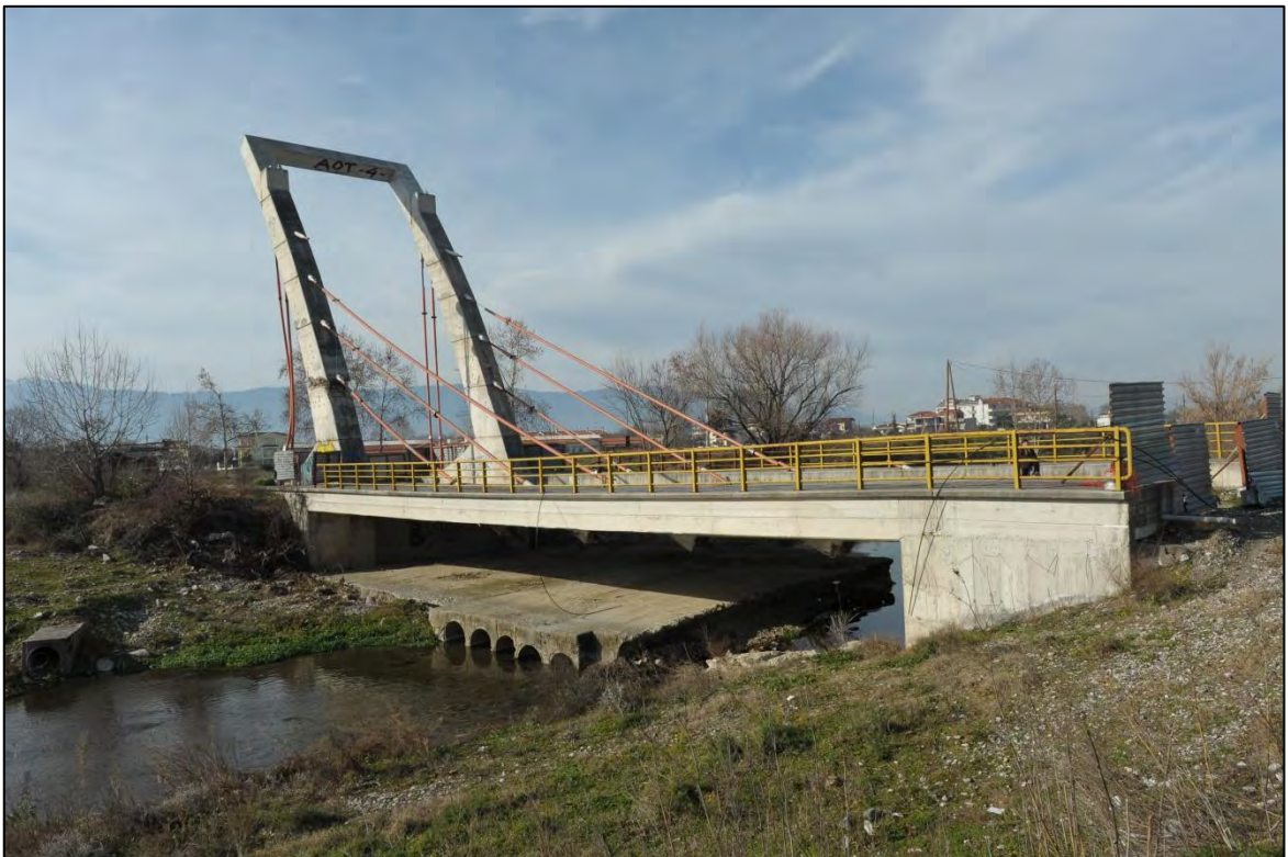
Εικόνα 13: Η γέφυρα «Καλατράβα» όπως είναι σήμερα
