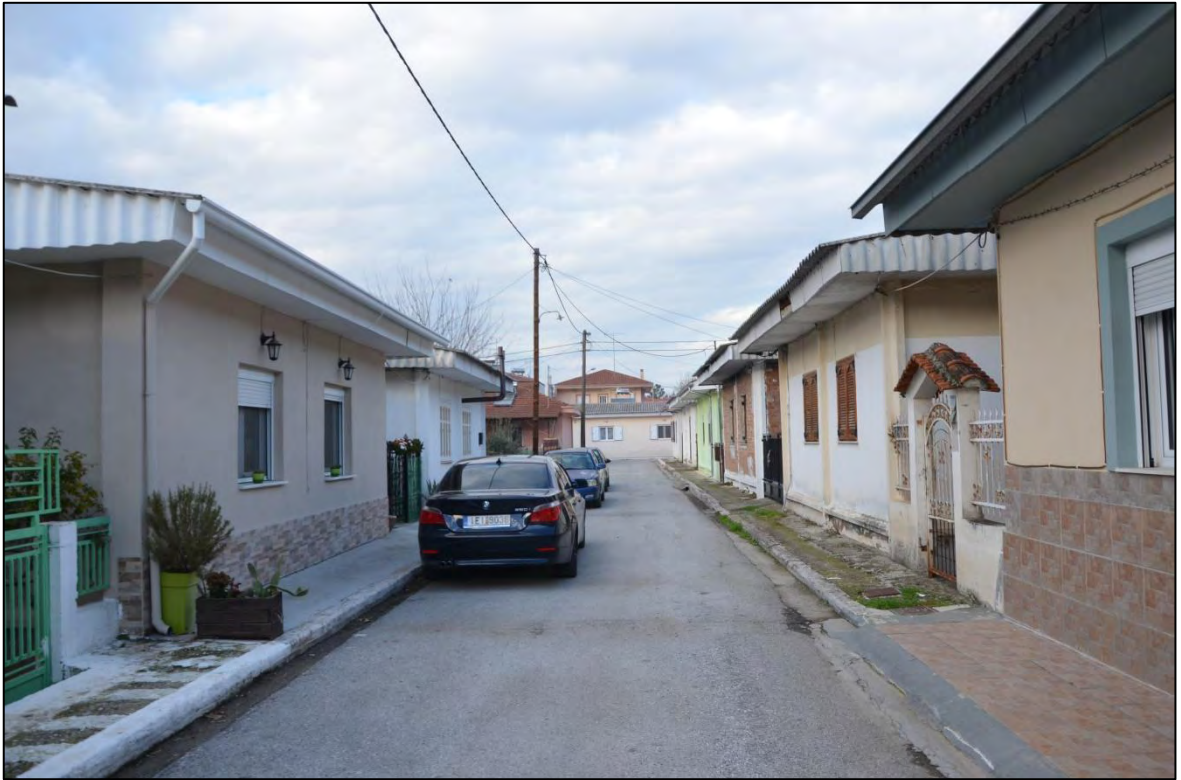
Εικόνα 10: Στέγες από αμίαντο στο ανατολικό τμήμα της συνοικίας «Σεισμόπληκτα»
