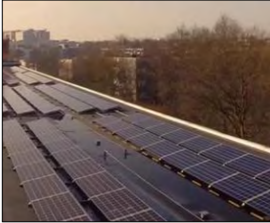
Εικόνα 22: Τοποθέτηση ηλιακών συλλεκτών στο Metrostation Reigersbos
