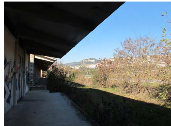
Επάνω, Εικόνα 34: η “οριζόντια” λιθόκτιστη αποθήκη [προσωπικό αρχείο] Κάτω, Εικόνα 35: άποψη της πλατφόρμας στην βόρεια πλευρά της “οριζόντιας” αποθήκης / διακρίνεται το Κάστρο της Λαμίας [προσωπικό αρχείο]
