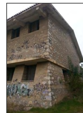
Εικόνες: 72 & 73 : ανατολική όψη / ράμπα φορτοεκφόρτωσης / σκελετός [προσωπικό αρχείο]
