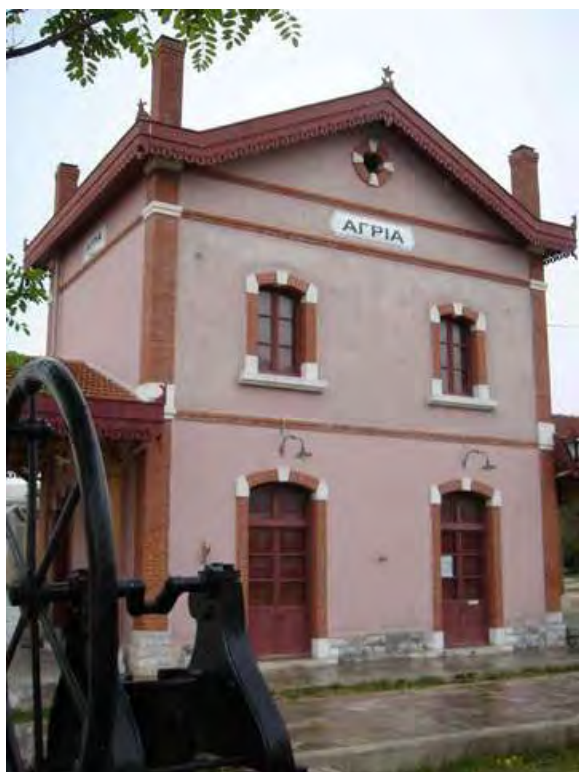
Εικ. 6: Ο σταθμός της Αγριάς
