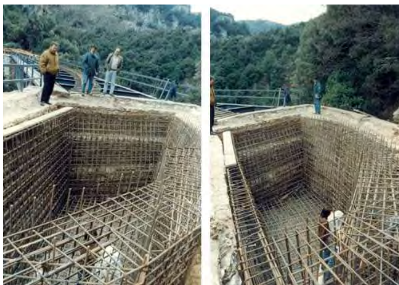
Εικ.10: Εργασίες αποκατάστασης των βάθρων της γέφυρας του Ταξιάρχη
