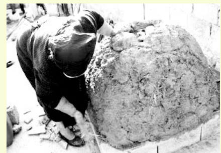
Εικόνα 40: Παλάμισμα του (επίχριση) του ξυλόφουρνου.
