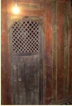
Εικόνα 55 : Η θύρα διαχωρισμού εντός του ιερού
