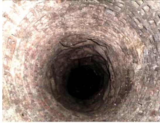
Εικόνα 45: Το φρεάτιο του αγιάσματος βάθους περίπου 13μ.
