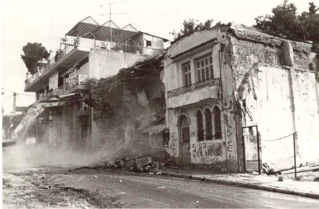
Εικόνα 30. Κατεδάφιση επισκοπικού μεγάρου
