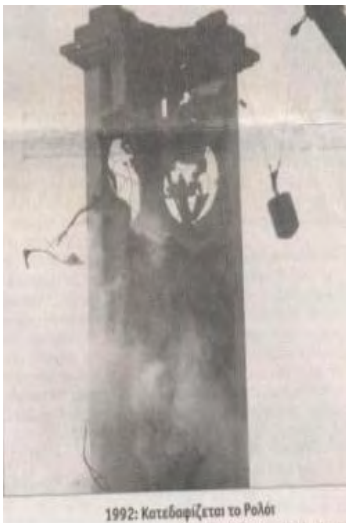
Εικόνα 29. 1992: Κατεδαφίζεται το Ρολόι της Λάρισας
