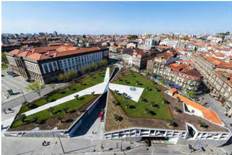
Εικόνα 3: Πάρκο-υπόγειος χώρος στάθμευσης στο Πόρτο. Πηγή: http://archquisition.blogspot.gr
