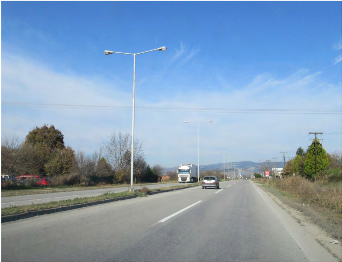
Εικόνα 1.3.6.1: Καλής ποιότητας οδικό δίκτυο (τμήμα εξωτερικού περιφ. δακτυλίου)
