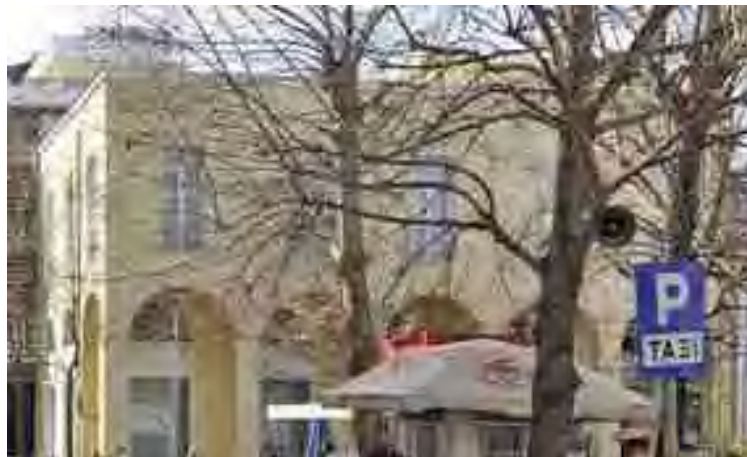
Εικόνα 42. Το κτίριο της πρώην Εμπορικής Τράπεζας (Πηγή: Δήμος Καρδίτσας)
