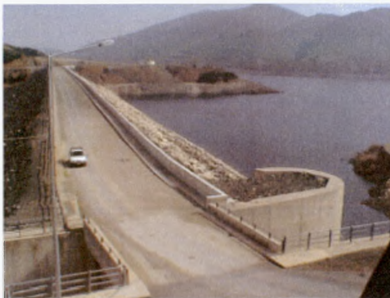
Εικόνα 7: Αποκατάσταση οδικού δικτύου περιοχής.
