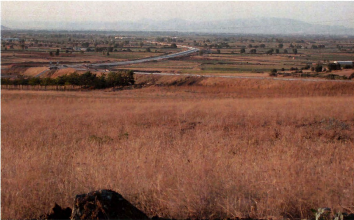
Φωτ. 7: Άποψη της περιοχής κατασκευής του Α/Κ Σμοκόβου περί τη Χ.Θ. 59+500 της εγκεκριμένης χάραξης (κατεύθυνση προς βορρά)
