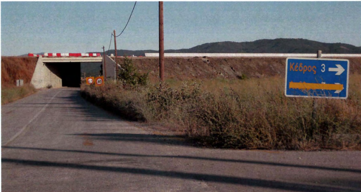
Εικόνα 5.1 Κάτω Διάβαση οχημάτων Αυτοκινητοδρόμου E65 (UP TR59.9)
