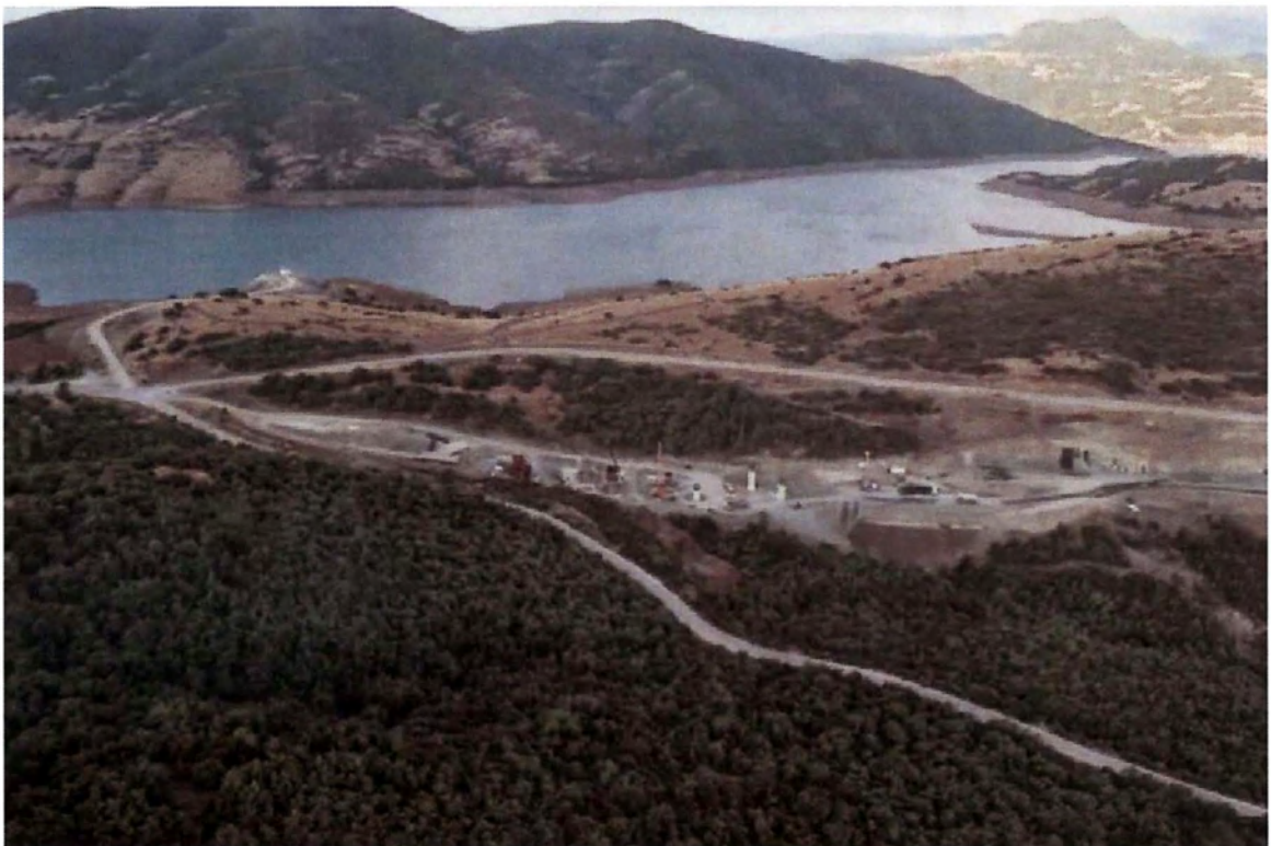
Φωτ. 2: Άποψη της περιοχής κατασκευής της γέφυρας περί τη Χ.Θ. 53+600 της εγκεκριμένης χάραξης (κατεύθυνση προς προς δυσμάς)
