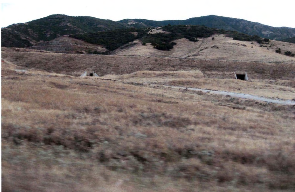
Φωτ. 6: Άποψη της περιοχής κατασκευής του Α/Κ Σμοκόβου περί τη Χ.Θ. 58+000 της εγκεκριμένης χάραξης (κατεύθυνση προς προς δυσμάς)
