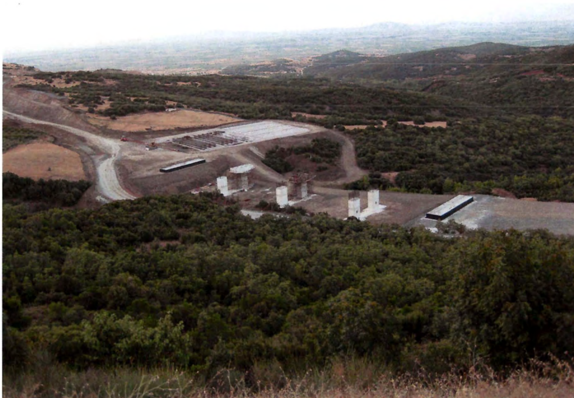
Φωτ.5: Άποψη της περιοχής κατασκευής της γέφυρας περί τη Χ.Θ. 54+850 της εγκεκριμένης χάραξης (κατεύθυνση προς ανατολάς)
