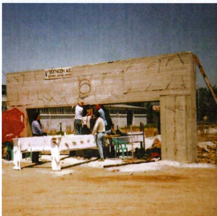
Εικόνα 2.2.1. – Πάσσαλοι με κεφαλόδεσμο από σκυρόδεμα, (ΓΕΩΓΝΩΣΗ Α.Ε.)
