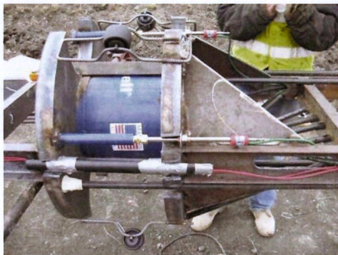
Εικόνα 4.5.1. Σύνδεση της κυψέλης Osterberg με το κλουβί οπλισμών [Tony Ruban et al, 2011]
