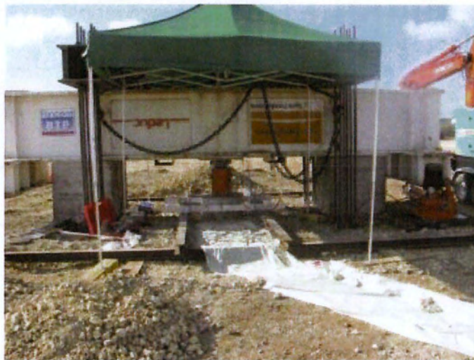
Πίνακας 6.3.1. Εγκατάσταση στατικής δοκιμαστικής φόρτισης πασσάλου [Orsetti V., & Rosa B., 2012]
