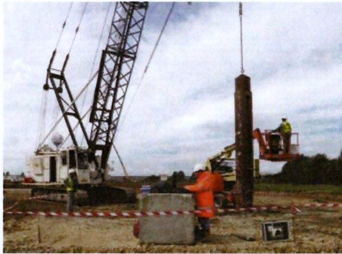
Πίνακας 6.3.2. Εγκατάσταση δυναμικής δοκιμαστικής φόρτισης πασσάλου [Orsetti V., & Rosa B., 2012]
