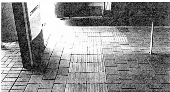
Φωτογραφία 14.24 - Ανάγλυφο πλακόστρωτο σε σημείο επιβίβασης.
