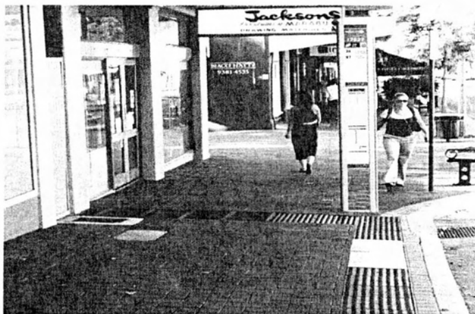
Φωτογραφία 14.25 - στάση λεωφορείων με ανάγλυφη πλακόστρωτη διαρρύθμιση
