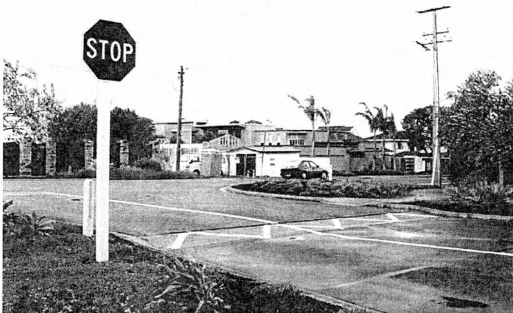
Φωτογραφία 6.29 - Διασταύρωση σε πλατφόρμα
