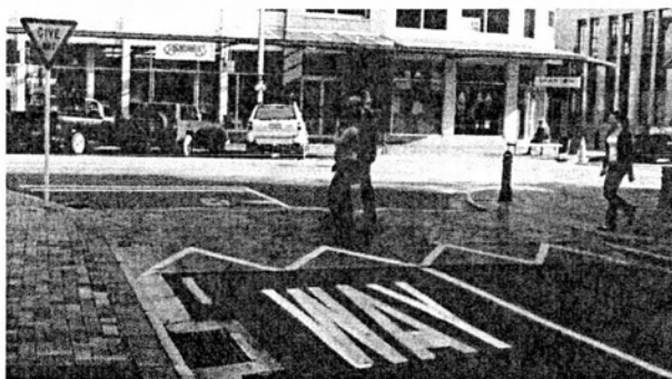
Εικόνα 6.22: Πλατφόρμα πεζών (Σημείωση: η ράμπα είναι καλά σημασμένη-πρέπει να επισημαίνονται ως διάβαση πεζών.)
