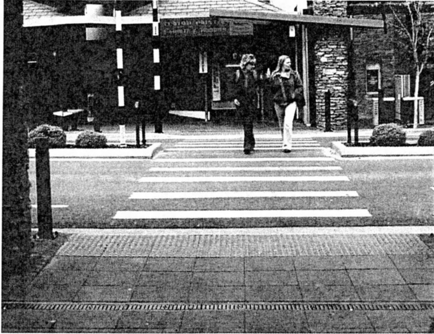
Φωτογραφία 6.11 - ισόπεδη διάβαση πεζών
