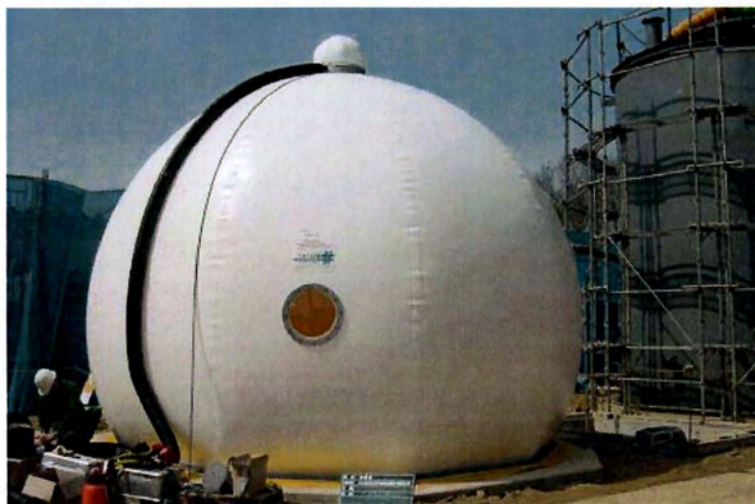
Εικόνα 15 Πλαστικός χωνευτήρας τύπου μπαλονιού
