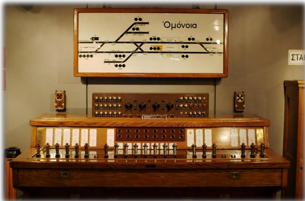
Σχήμα 2.9: Χειριστήριο Σταθμάρχη σιδηροδρομικού σταθμού Ομόνοιας
