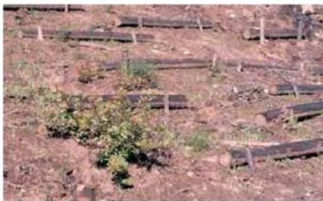
Εικόνα 32. «Διπλά κορμοδέματα» σε απότομη πλαγιά για τη συγκράτηση μεγα-λύτερου όγκου διαβρωμένου εδάφους. Δειλά – δειλά αρχίζει και η φυσική αναγέννηση.
