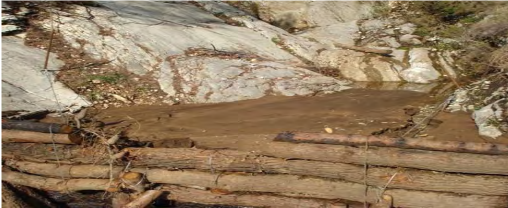
Εικόνα 26. Υλικά που συγκρατήθηκαν από ξυλόφραγμα στην Πελοπόννησο
