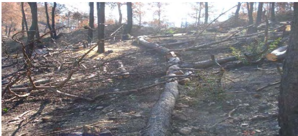
Εικόνα 25. Κατασκευή κορμοδεμάτων στη στην Νήσο Ρόδο
