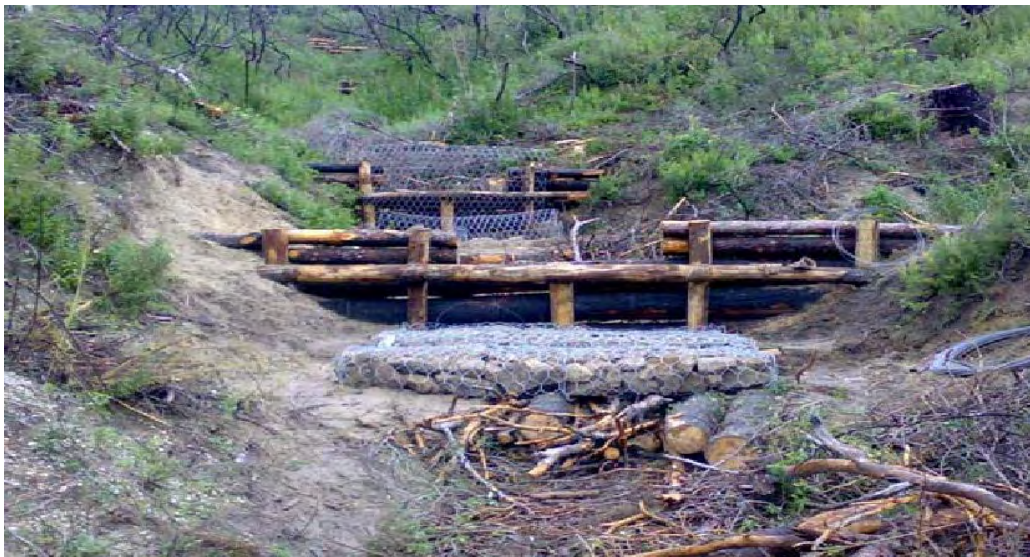
Εικόνα 27. Ξυλοφράγματα στην περιοχή της Κασσάνδρας με "ποδιά" απόσυρματόπλεχτα κιβώτια (σαραζανέτ)
