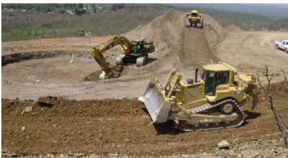
Εικόνα 10: Εκσκαφή για την εγκατάσταση αιολικού πάρκου
