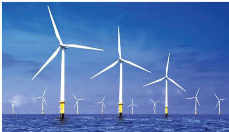
Εικόνα 7 : Θαλάσσιο αιολικό πάρκο
