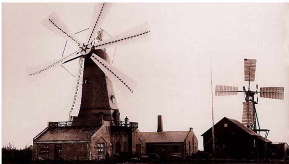
Εικόνα 4 : Δυο από τις πρώτες ανεμογεννήτριες που χρησιμοποιήθηκαν για ερευνητικά τεστ το 1897 στο Askov της Δανίας κατασκευασμένα από το μετεωρολόγο PoullaCour που θεωρείται πρωτοπόρος στην αιολική ενέργεια
