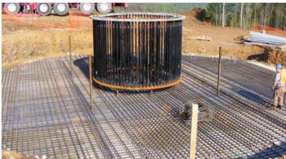
Εικόνα 11:Θεμελιακός κλωβός στήριξης πύργου ανεμογεννήτριας
