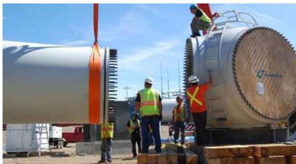
Εικόνα 12:Συναρμολόγηση των πτερυγίων της ανεμογεννήτριας στο ρότορα
