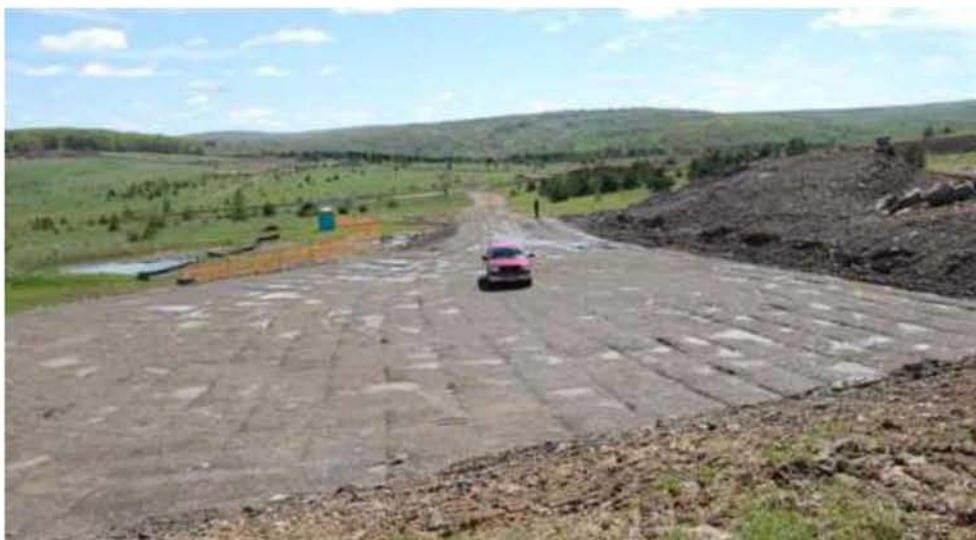
Εικόνα 9: Περιοχή έτοιμη προς δημιουργία αιολικής εγκατάστασης
