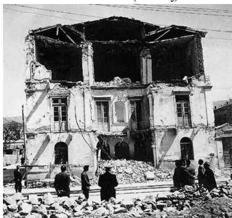
Εικόνα 3.1.2: Κατεστραμμένο σπίτι από το σεισμό του 1955 (Βόλος)
