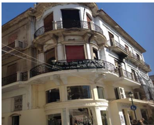
Εικόνα 4.1.2: Υφιστάμενη κατάσταση τμήματος της καπνοβιομηχανίας Ματσάγγου
