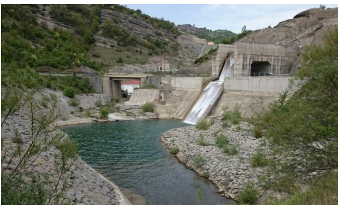
Εικόνα 19: Υδροηλεκτρικό Φράγμα Πραμόριτσας
