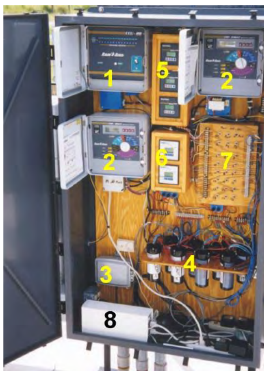
Εικόνα 3.11. Πίνακας ελέγχου ενός κεντρικά ελεγχόμενου συστήματος άρδευσης εσπεριδοειδών: (Boman et al., 2015, fig. 14)
