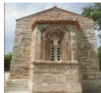
Εικ. 42 Ανατολική όψη Ναού Αγίου Νικολάου (Κανάλια)
