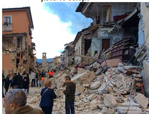
Εικόνα 36: Αματρίτσε 06 - κεντρικός δρόμος μετά το σεισμό
