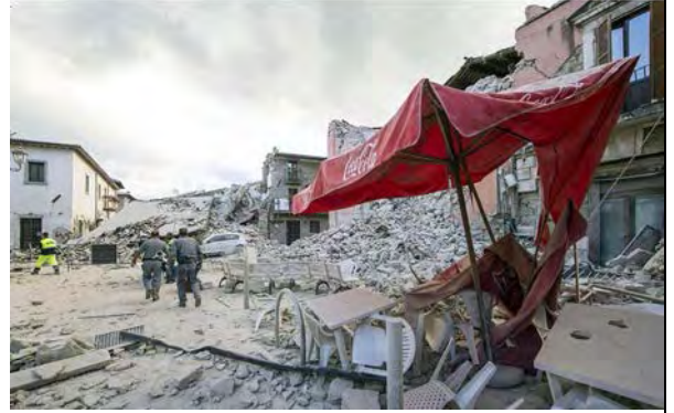
Εικόνα 38: Αματρίτσε 08- μετά το σεισμό
