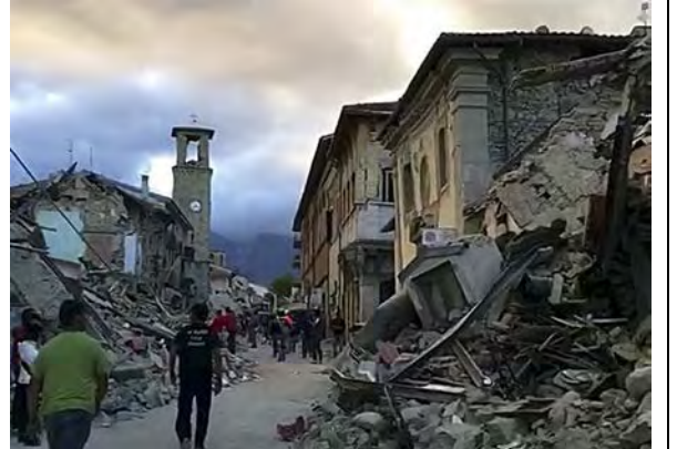
Εικόνα 40: Αματρίτσε 10- μετά το σεισμό
