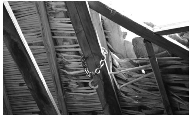
Λεπτομέρεια από την οροφή της στέγης του πύργου
