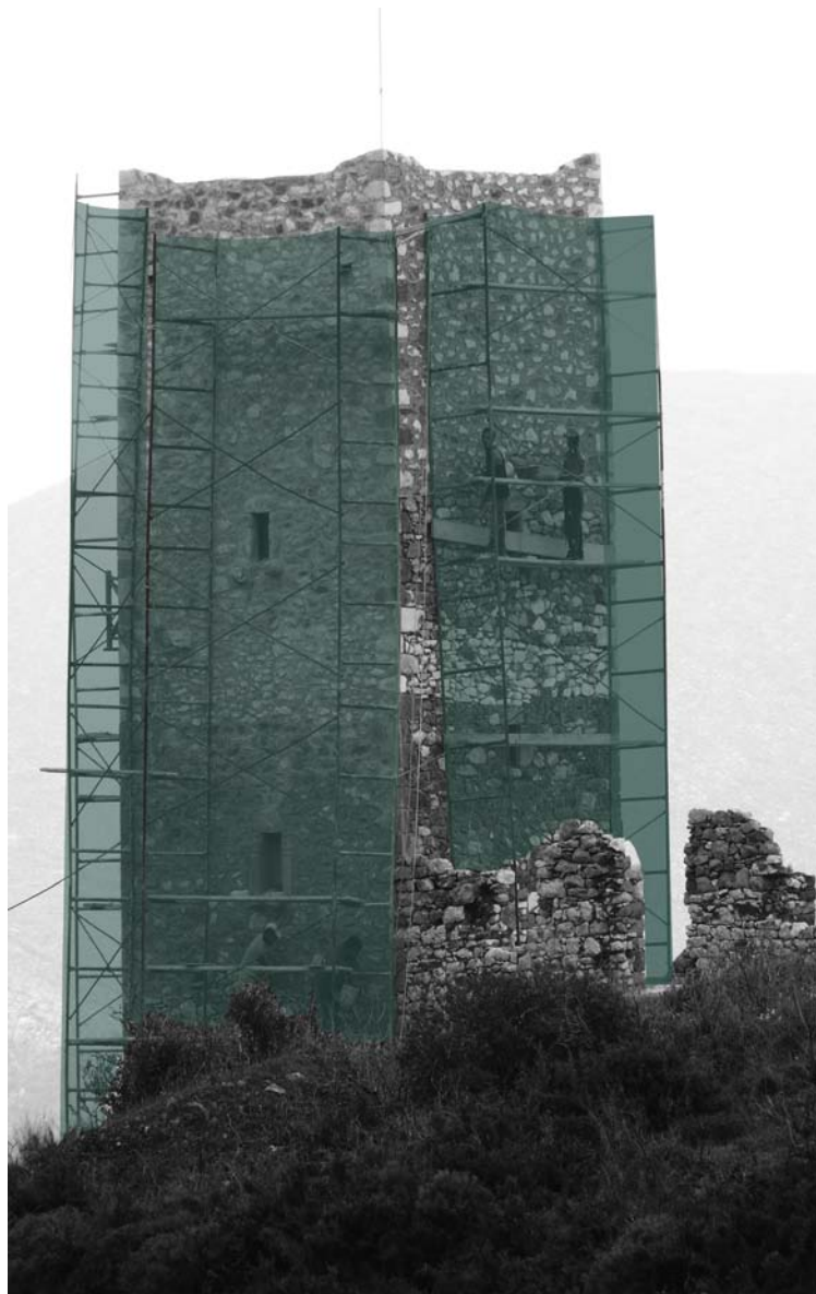
διαδικασίες ενίσχυσης του ερειπίου
