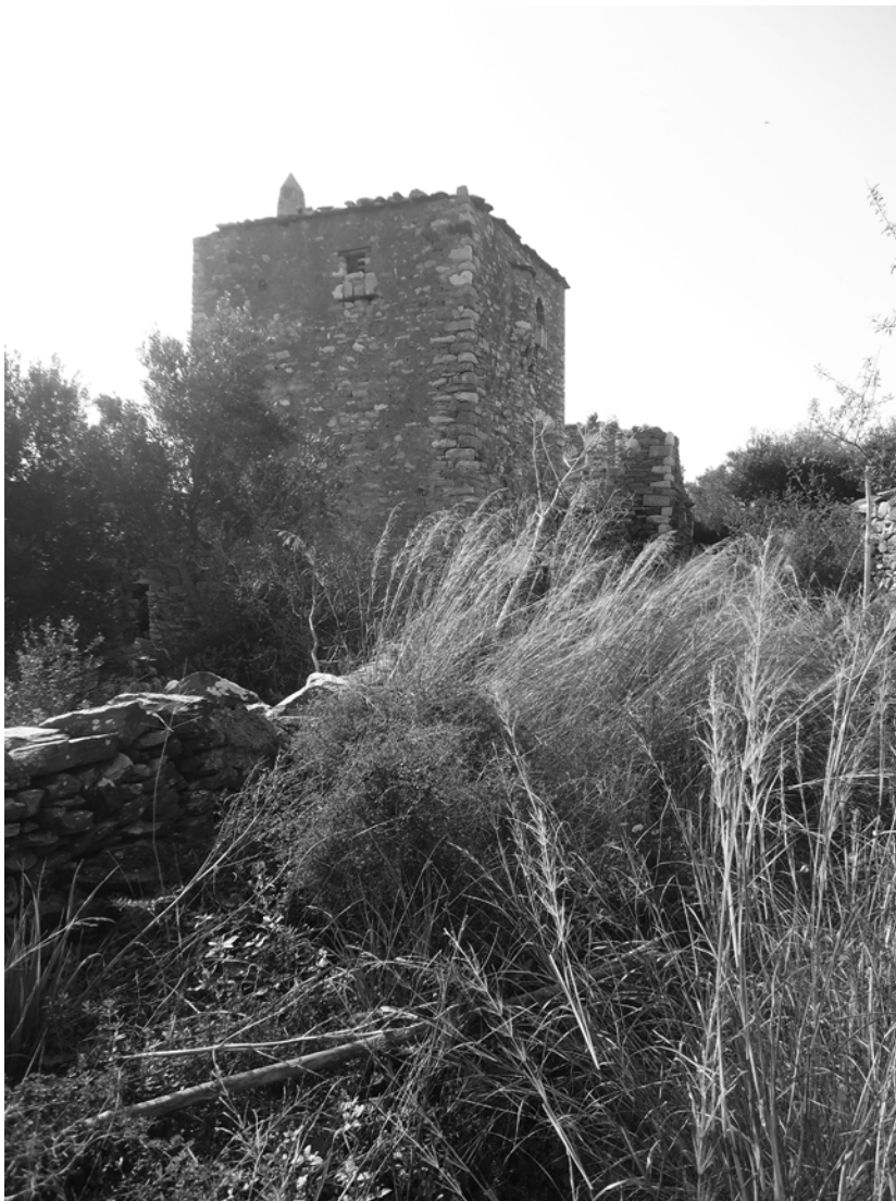
ανατολική όψη της πυργοκατοικίας στην Τραχήλα
