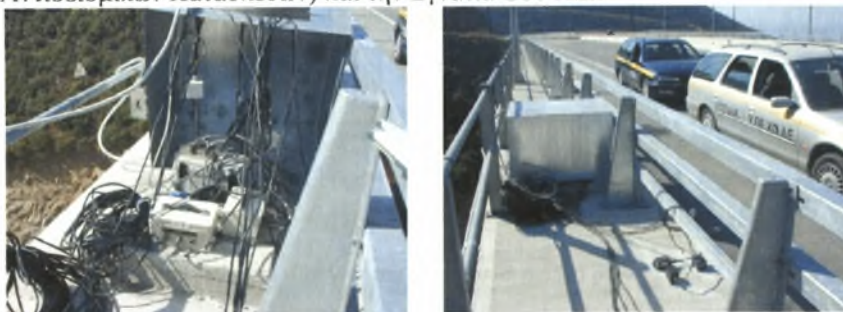
Σχήμα 7.3. Κεντρική καταγραφική μονάδα στην χαραδρογέφυρα της Καβάλας.
