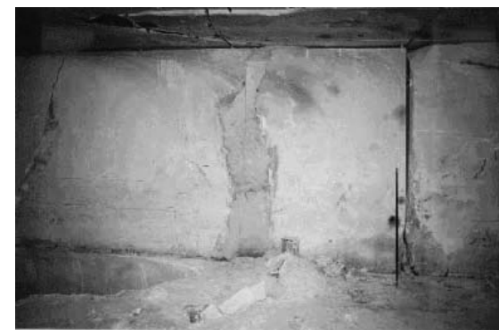
Εικόνα 4: Κομός σε στύλο πληρωμένος με ένεμα
