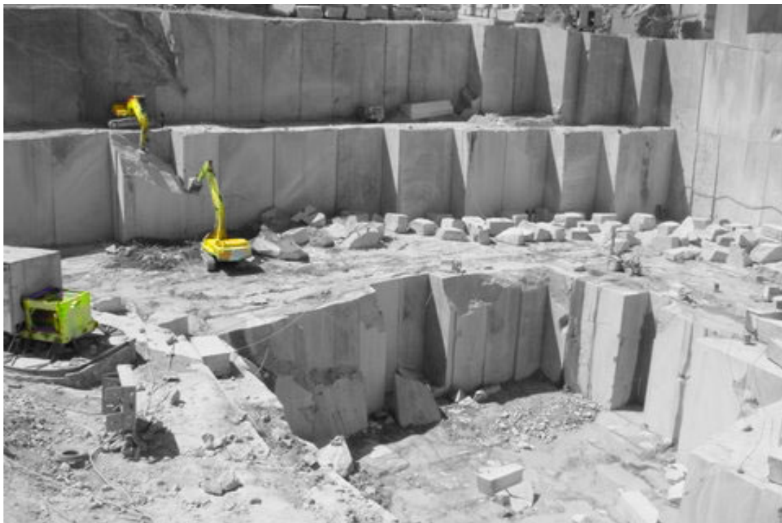
Εικόνα 6: Δημιουργία βαθμίδων και απομάκρυνση με εκσκαφτήρες
