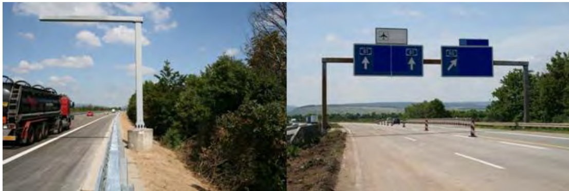
Εικόνα 2.2.2 Πινακίδες και γέφυρες σήμανσης
