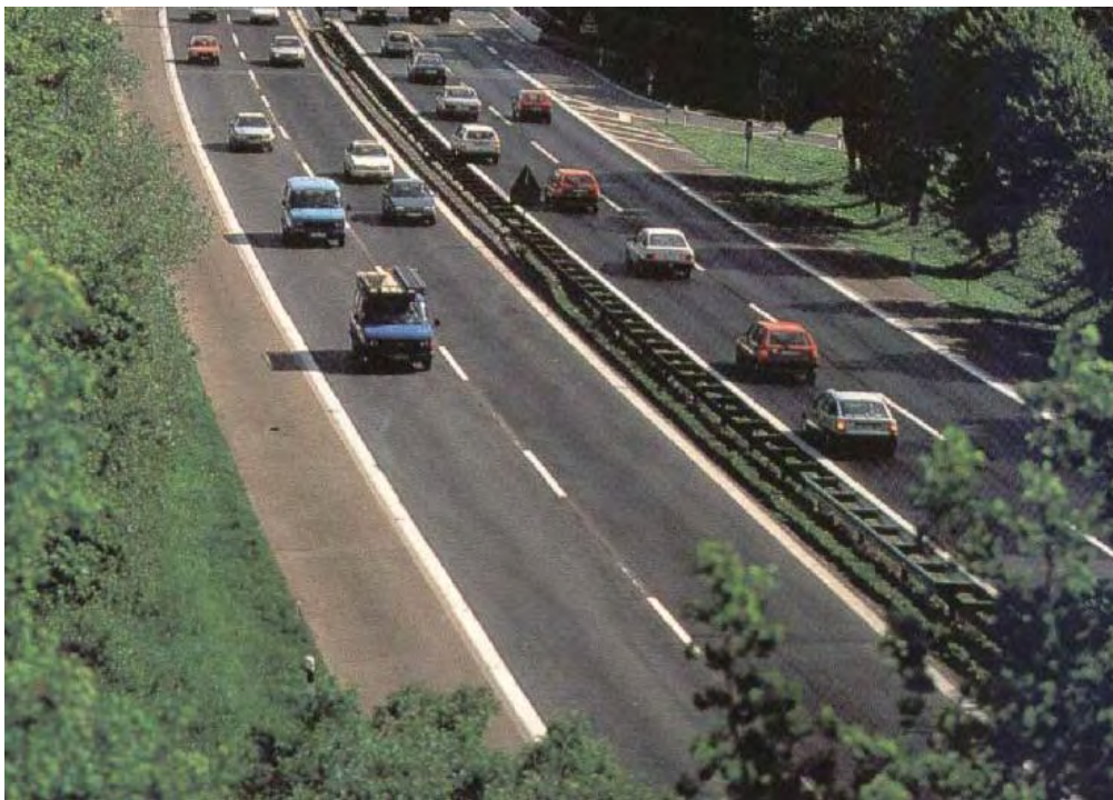
Εικόνα 2.4.3: Ενισχυμένο αμφίπλευρο στηθαίο σε ενδιάμεσο χώρο αυτοκινητοδρόμου.
