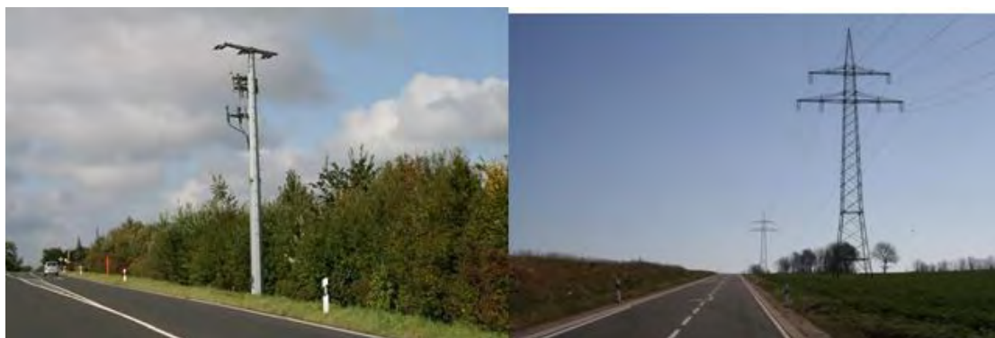
Εικόνα 2.2.3 Στύλοι δικτύων κοινής ωφέλειας (όπου μία σύγκρουση του οχήματος με αυτά θα είχε δυσάρεστες συνέπειες)
