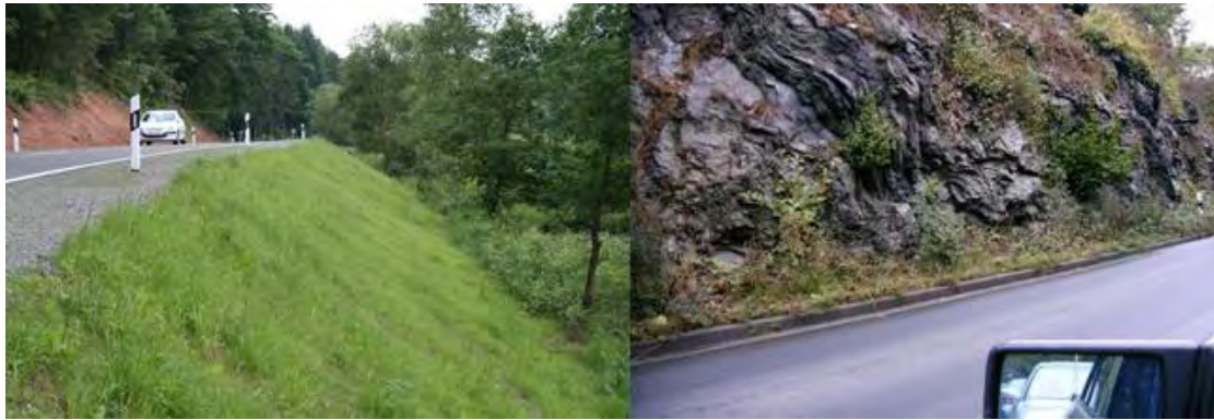
Εικόνα 2.2.4 Επιχώματα και ορήγματα με απότομες κλίσεις (όπου υπάρχει κίνδυνος ανατροπής ή απότομης πτώσης του οχήματος)
