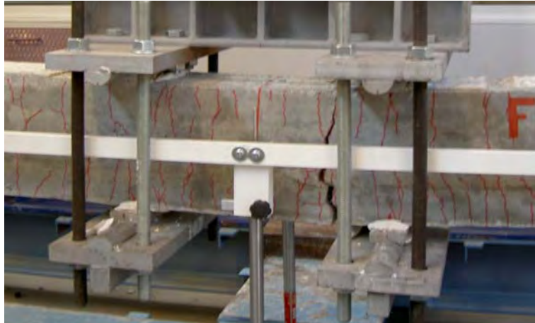
Σχ. 5.39: Εικόνα αστοχίας της δοκού ινοπλισμένου τσιμεντοκονιάματος με συμβατικό οπλισμό (Τύπος Γ) στην πειραματική δοκιμή στατικής ανακυκλιζόμενης κάμψης τεσσάρων σημείων.
