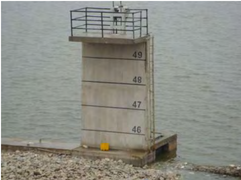
Εικόνα 4: Μετρητής στάθμης νερού
