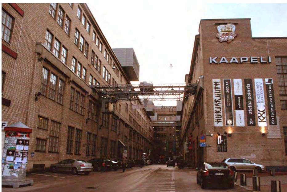
Φωτο8: Η κεντρική είσοδος του Cable factory
