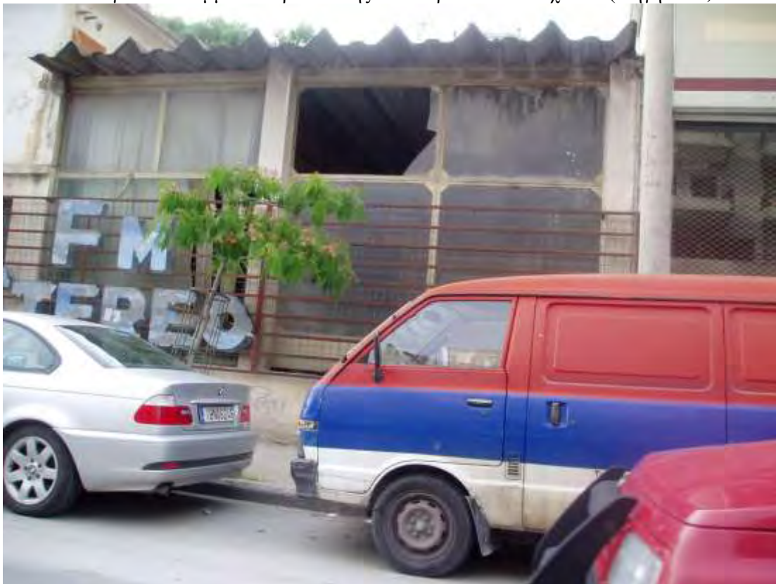
Εικόνα 26: Εγκαταλελειμμένο κτίριο επί της οδού Ηρώων Πολυτεχνείου (Πηγή: Ιδία)
