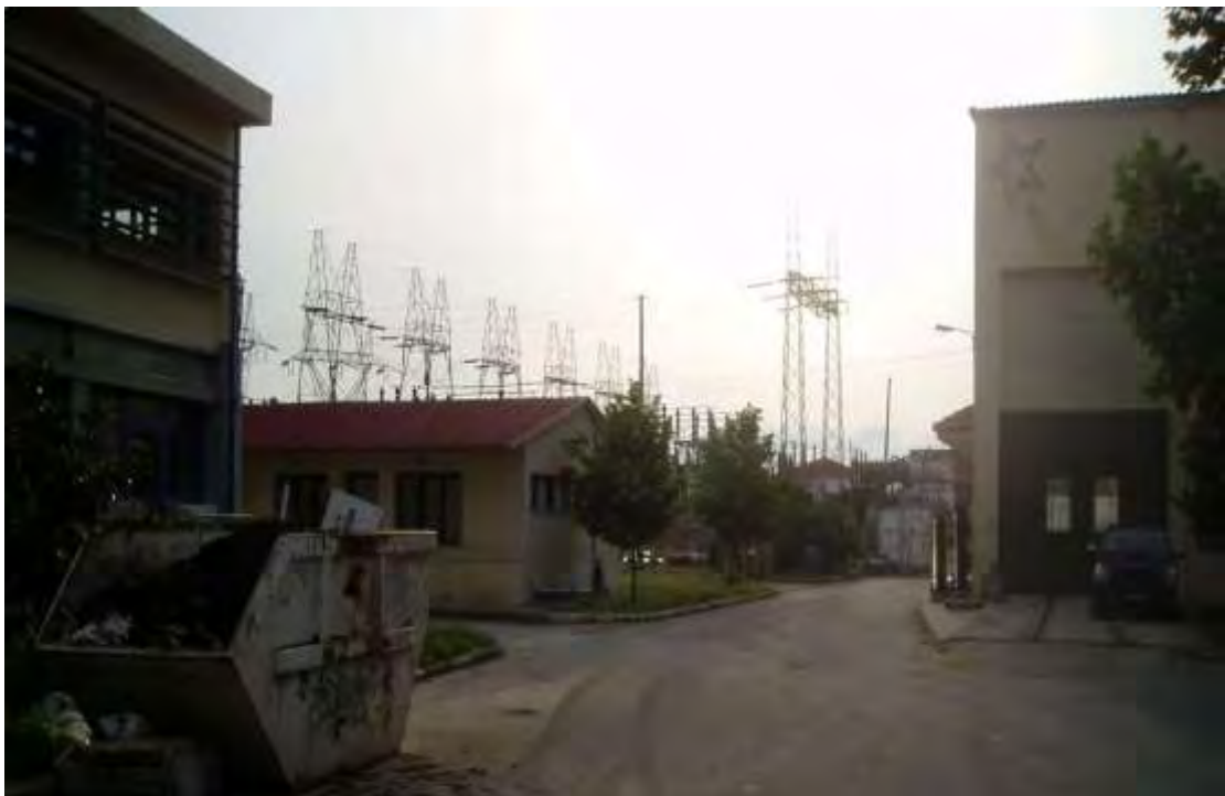
Εικόνα 12: Υποσταθμός της ΔΕΗ στο Λειβαδάκι Λάρισας (Πηγή: Ιδία)
