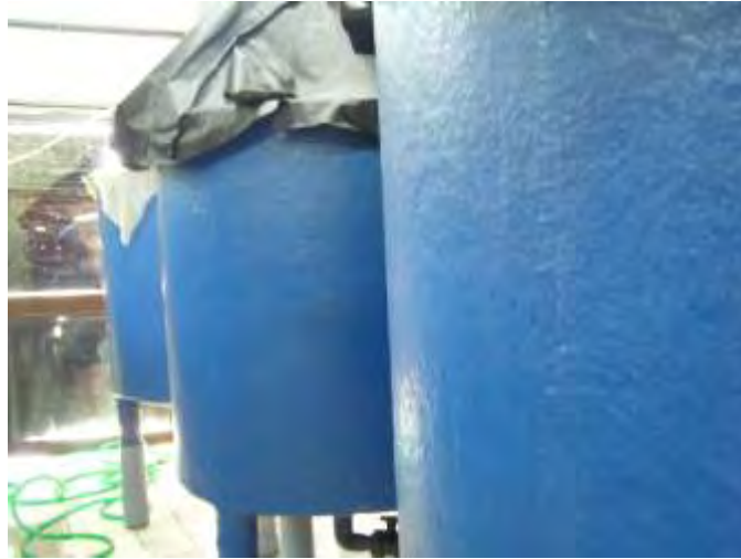
Εικόνα 3.2.2.1: Εξωτερικό μέρος δεξαμενών
