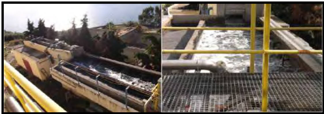
Εικόνα 8: Μονάδα αμμοσυλλογής και λιποσυλλογή
