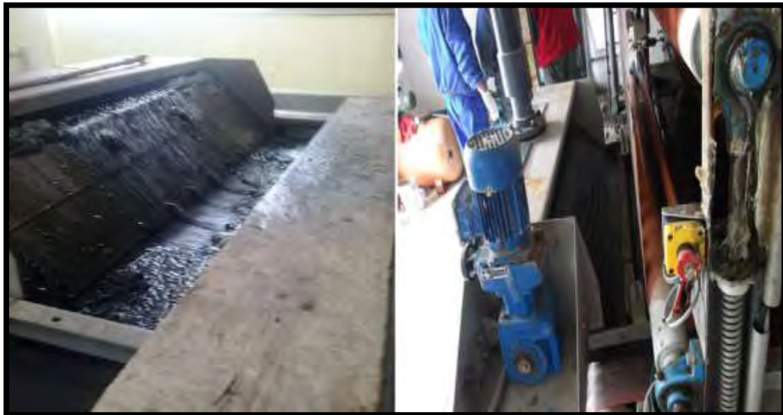
Εικόνα 18: Υδαρή ιλύς σε ταινιοφιλτροπρεσσα.
