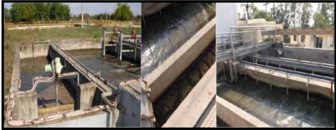
Εικόνα 7: Μονάδα αμμοσυλλογής και λιποσυλλογή.
