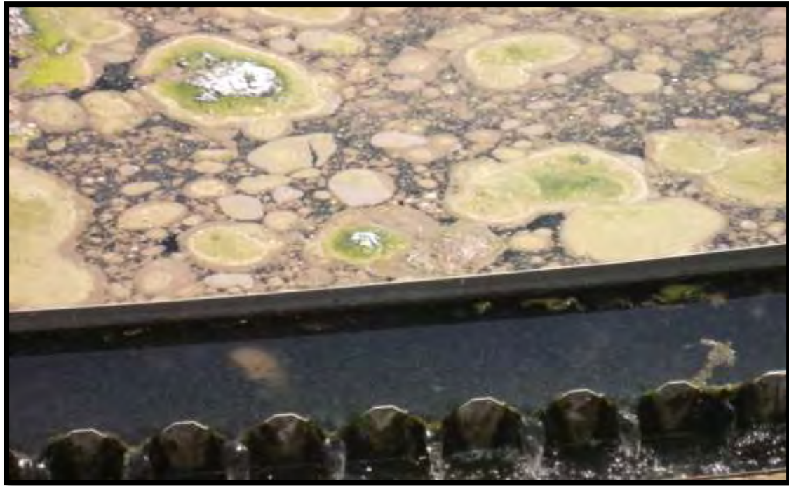
Εικόνα 14: Θολή εκροή δεξαμενής καθίζησης.
