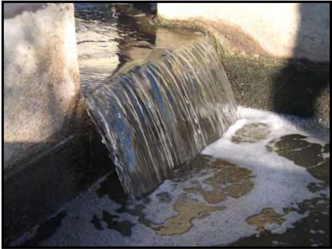
Εικόνα 22: Εκροή επεξεργασμένου λύματος
