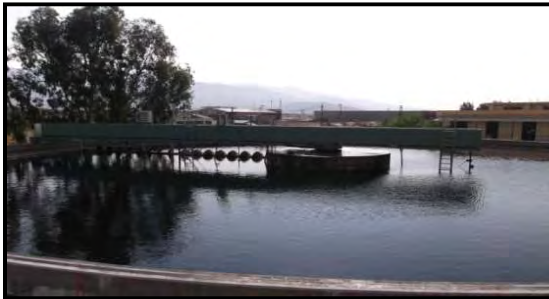
Εικόνα 24: Δεξαμενή δευτεροβάθμιας καθίζησης
