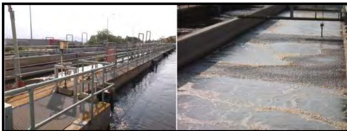
Εικόνα 23: Δεξαμενή αερισμού
