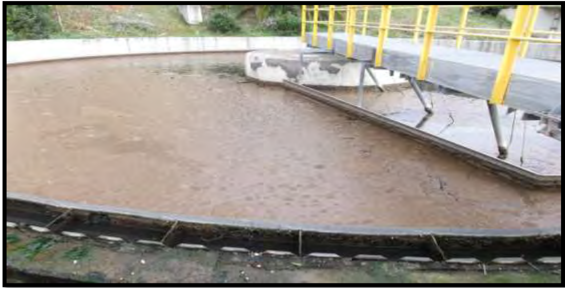
Εικόνα 15: Ανύψωση ιλύος σε δεξαμενή καθίζησης
