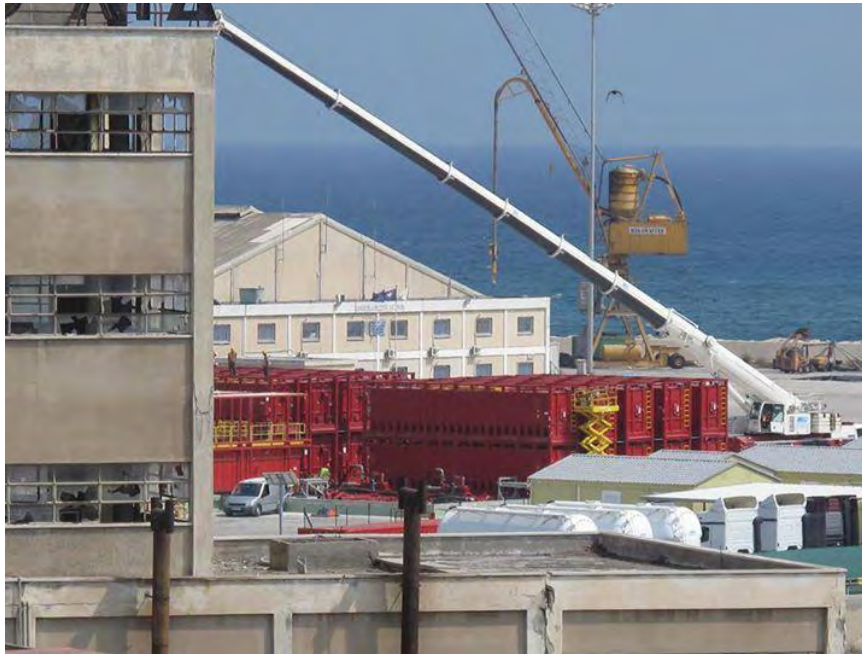
Εικόνα 3.6./1: Εγκαταστάσεις Εργοστασίου Παραγωγής Λάσπης στο λιμάνι Λάρνακας
