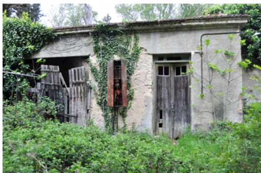
φωτογραφίες υφιστάμενων κτιρίων
