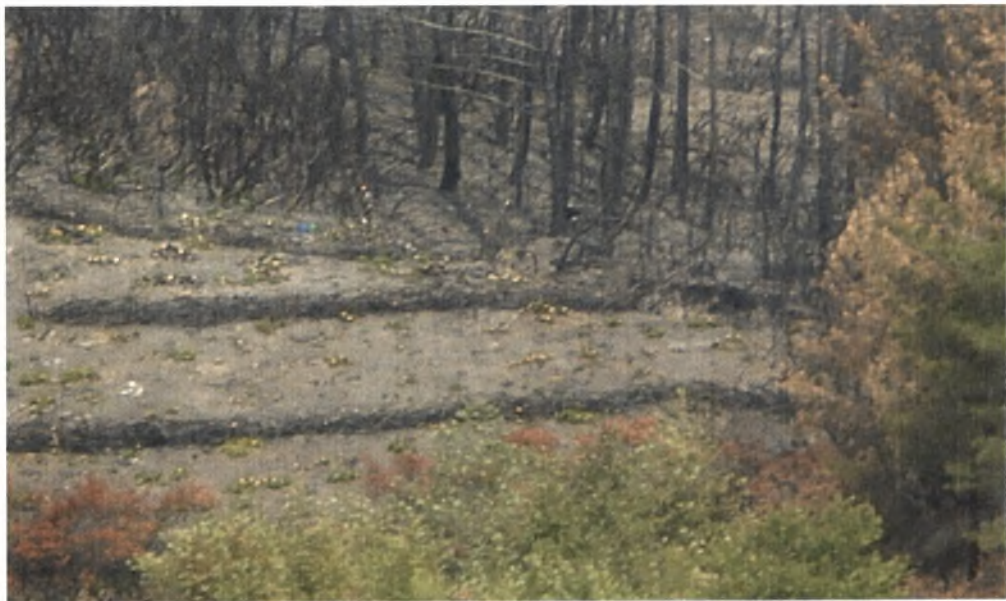
Εικόνα7. Τα αντιπλημμυρικά & αντιδιαβρωτικά έργα της λεκάνη απορροής του φράγματος Παναγιώτικο.
