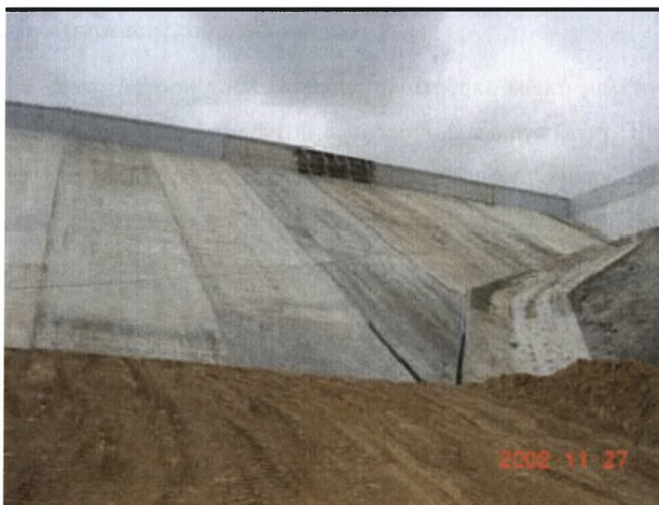
Εικόνα 11: Το φράγμα Παναγιώτικο στη φάση κατασκευής.
