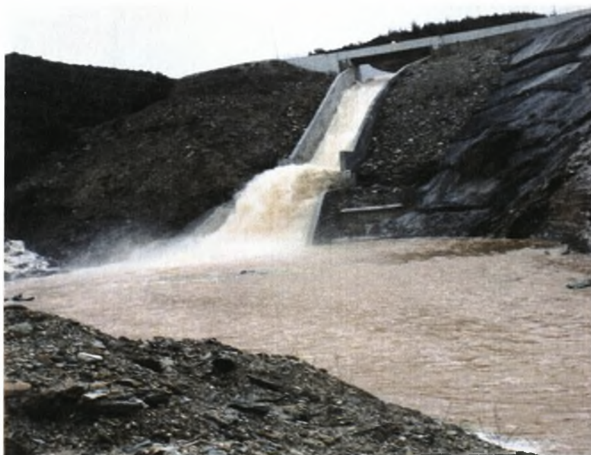
Εικόνα 8:Υπερχειλιστής ασφαλείας
