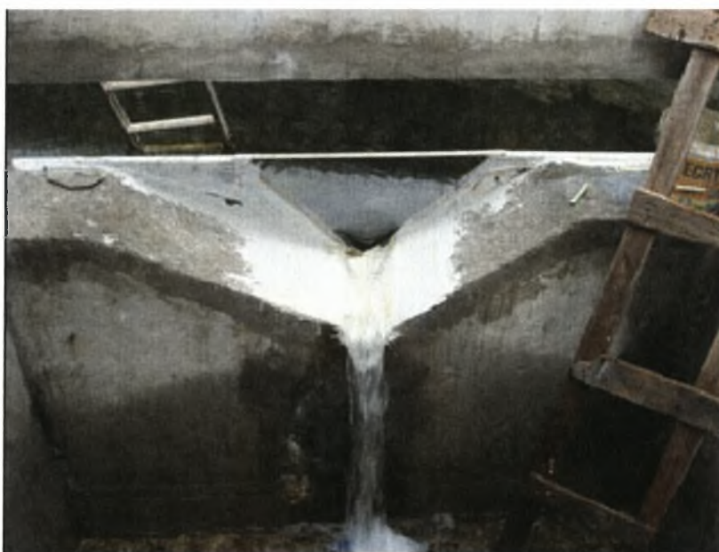
Εικόνα 14: Μέτρηση διαρροών στα κατάντη
