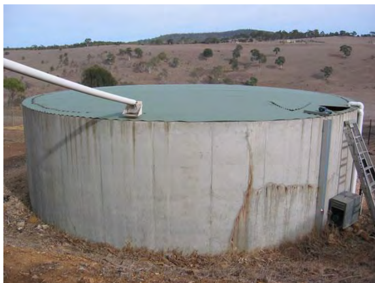
Σχήμα 1.2: Επίγεια κυκλική δεξαμενή από οπλισμένο σκυρόδεμα
