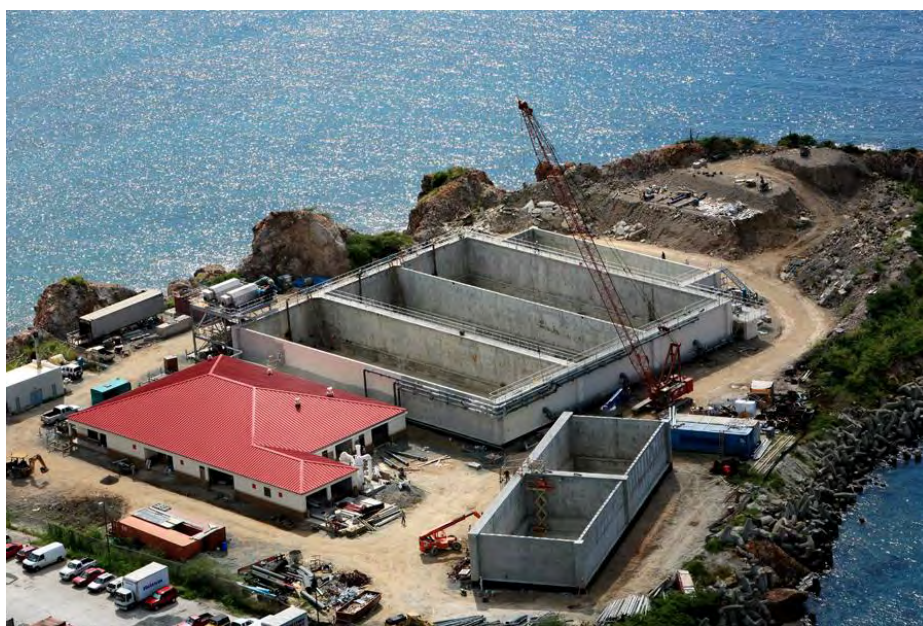
Σχήμα 1.3: Επίγεια ορθογωνική δεξαμενή από οπλισμένο σκυρόδεμα
