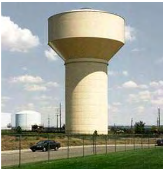
Σχήμα 1.1: Υπερυψωμένη δεξαμενή νερού στο Colorado των Ηνωμένων Πολιτειών
